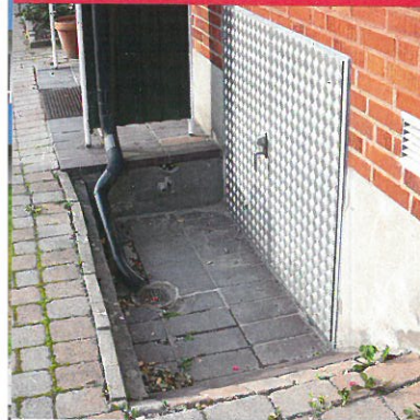
FÖRE: De gamla sopskåpen låg under marknivå och regnvattnet leddes praktiskt taget in i huset.
