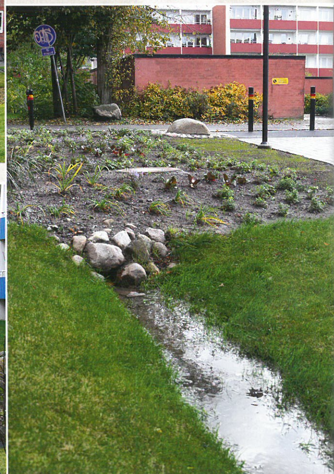
En av de nyplanterade rabatterna. Undertill syns vattnet strömma mot fördröjningsdammen.
