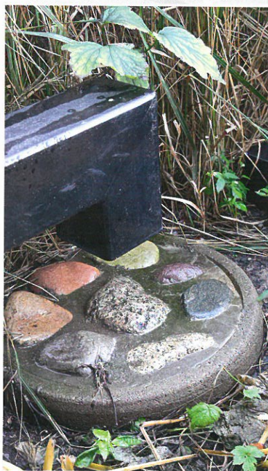
Stupröret slutar vid en betongplatta som fungerar som erosionsskydd och fördelar vattnet i bädden.
