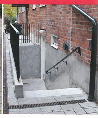
EFTER: Trappan har breddats och vattnet från stuprörets leds via markrännor bort från huset.
