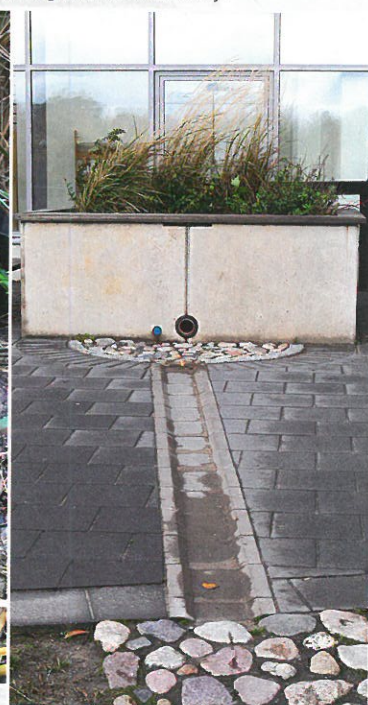
Överskottsvattnet leds mot ett svackdike som avslutas i gräsmatta.
